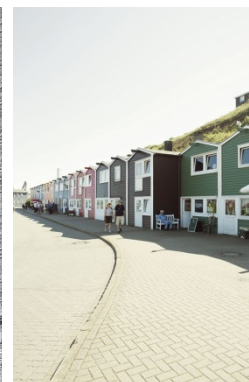
Die stählernen Fachwerk-Konsolen sind in Helgoland-Gelb gestrichen. (Foto: Kai-Uwe Gundlach via awmagazin.de)
