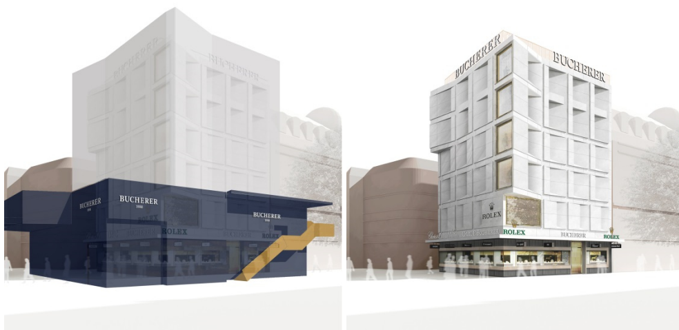
Für die Bauzeit entwarfen office haratori einen Bauzaun mit integriertem Treppenaufgang. 2018 präsentiert der Juwelier sein neues Kleid. zur temporären Verkaufsfläche.
