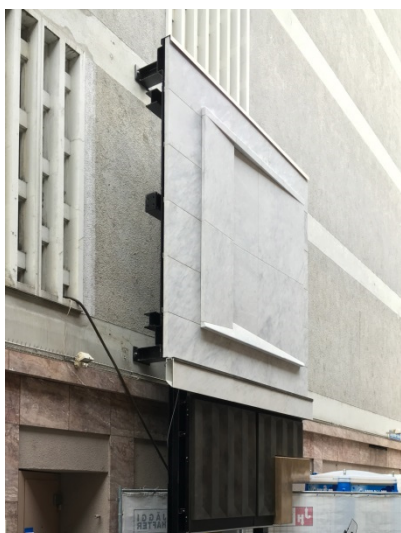
Fassaden-Mockup: Oben gefräster Marmor, unten Bronzeguss.
