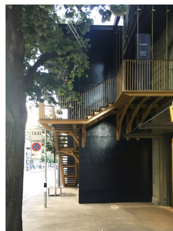
Der Windfang schützt den Eingang zum temporären Verkaufslokal im ersten Obergeschoss des Nachbarhauses.
